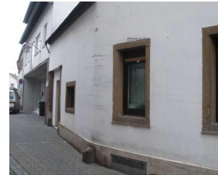
**Abb. 11: Schäden an Gebäuden durch vorbeifahrende Fahrzeuge**
