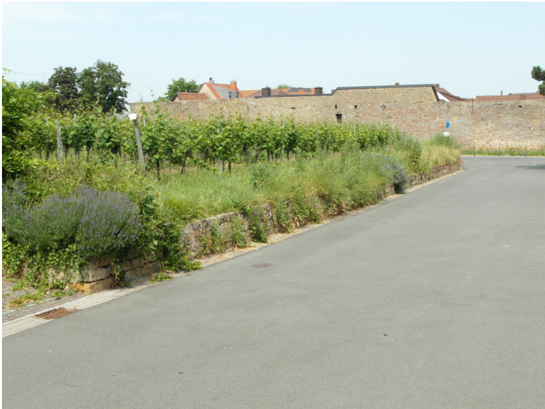
Abbildung 9 Bereich mit geplantem Abbruch eines rund 20 m langen Mauerabschnitts zur Anbindung der Anwohnerstraße
