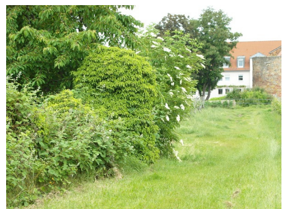
Abbildung 14: Gehölze am Turm der Stadtmauer
