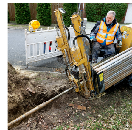
Anwendung des Spülbohrverfahrens
