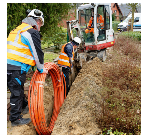
Klassischer Tiefbau per Minibagger
